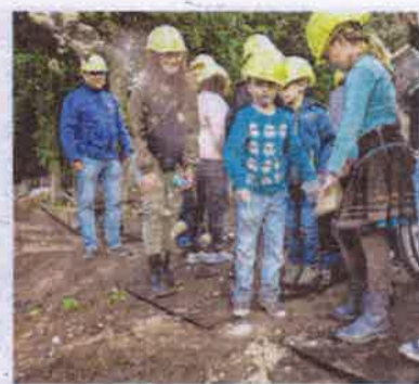
Start van de bouw. FOTO MARIEKE WUNTJES
